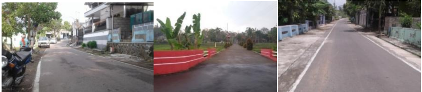
Gambar II.8 Jalan lingkungan menuju lokasi budidaya perikanan di Kecamatan Karangpandan
